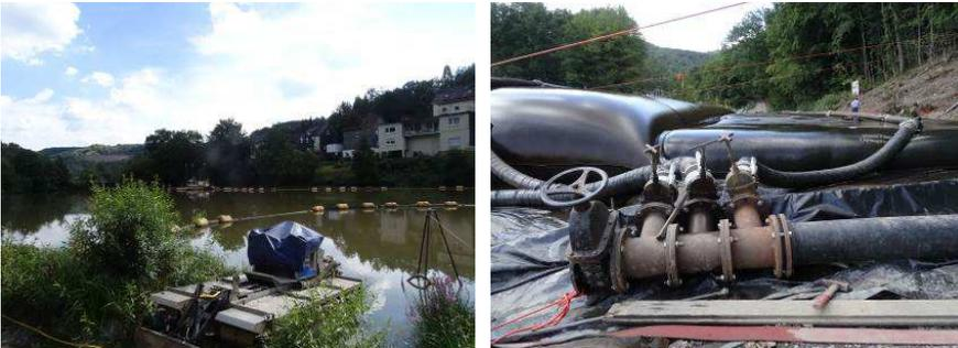
Arbeiten müssen große Mengen Sedimente aus dem Pocheweiher entfernt werden. In einem besonderen Verfahren werden die Sedimente mit einem Schwimmbagger gelöst und zum Ufer gepumpt. Das Sediment-Wasser-Gemisch wird mit einem Flockungsmittel versetzt und in große Geotextilschläuche gefördert. Dort entwässert das Material in wenigen Wochen und kann dann abgebaggert und mit LKWs zur Entsorgung abtransportiert werden.
