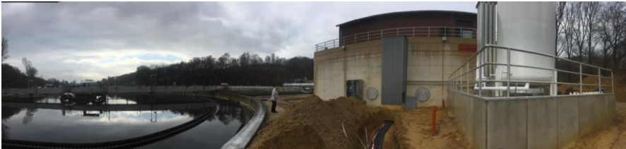
Ozonungsanlage Kläranlage Aachen-Soers (Quelle: Vladislav Larichev)
