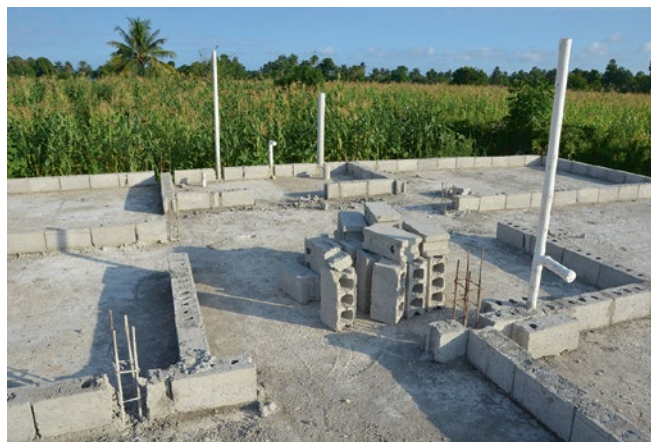
Bild 5: Die Grundmauern des ersten Waisenhauses stehen
