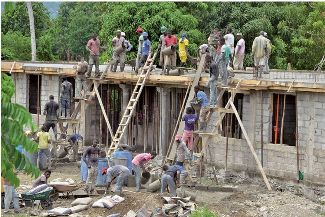
Bild 8: Bildung für die Zukunft – die Betondecke für drei Klassenräume wird gegossen
