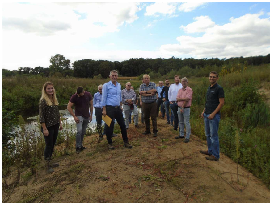
Auf der Baustelle (Quelle: Wolfgang Hennemann)
