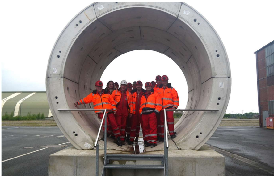
Exkursionsteilnehmer im Modell des Grubenwasserkanals (DN 3600 Tübbing) (Quelle: Wolfgang Hennemann)
